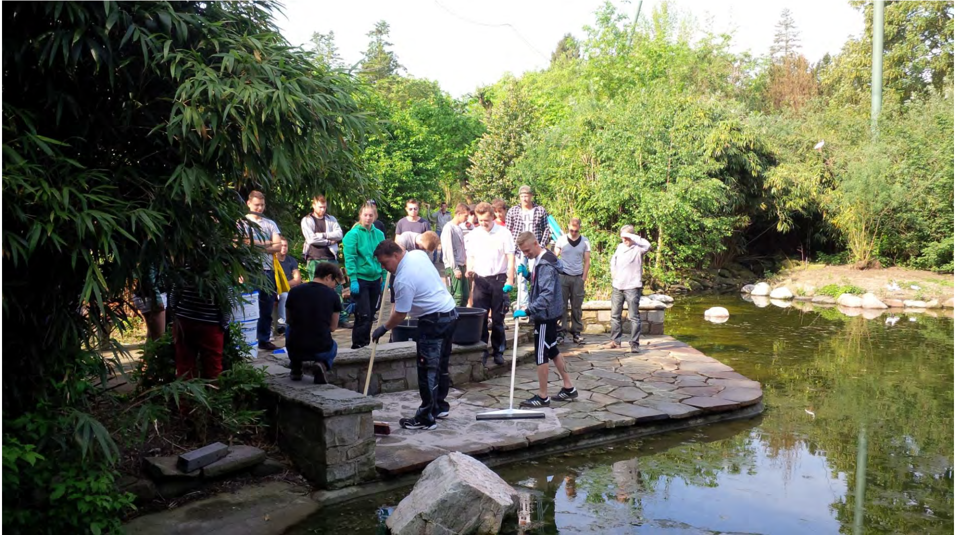
Anschließend wurde das fertige Material eingebaut.
